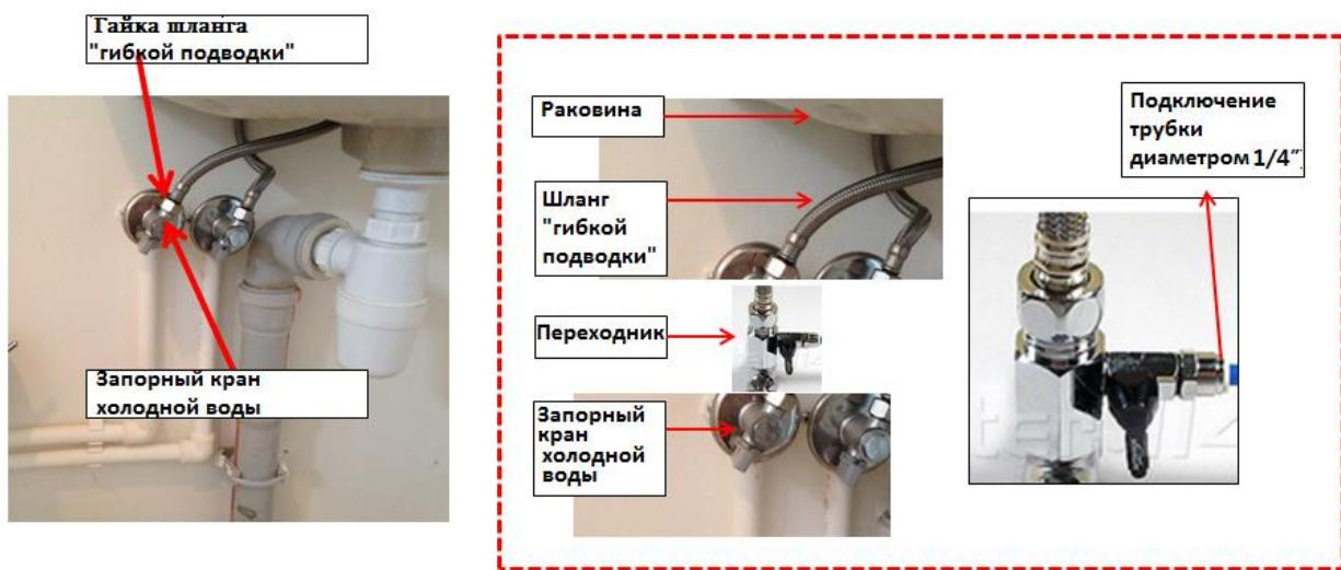
1. Подключите полипропиленовый трубопровод (1/4 дюйма) к переходнику (не допускайте использование слишком коротких или сильно изогнутых шлангов). Соедините второй конец полипропиленового трубопровода с г-образным фитингом поставляемым в комплекте
