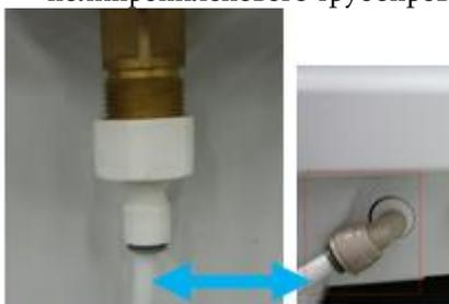
3. Откройте запорный кран холодной воды. При обнаружении следов утечки в зоне соединения шланга закройте запорный кран и проверьте все части соединения. Устраните утечку. Убедитесь, что подаваемая вода не течет ни внутри и ни снаружи. Откройте запорный кран холодной воды.
