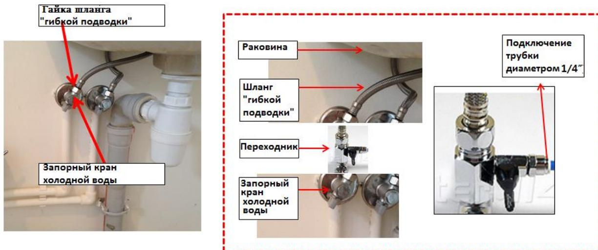
1. Перекройте подачу воды при помощи запорного крана.
